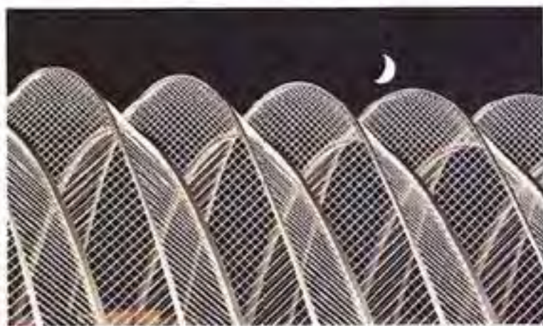
DETALHE DA CIDADE DAS ARTES E DA CIÊNCIA DE VALENCIA, PROJETO DE CALATRAVA E FELIX CANDELA
